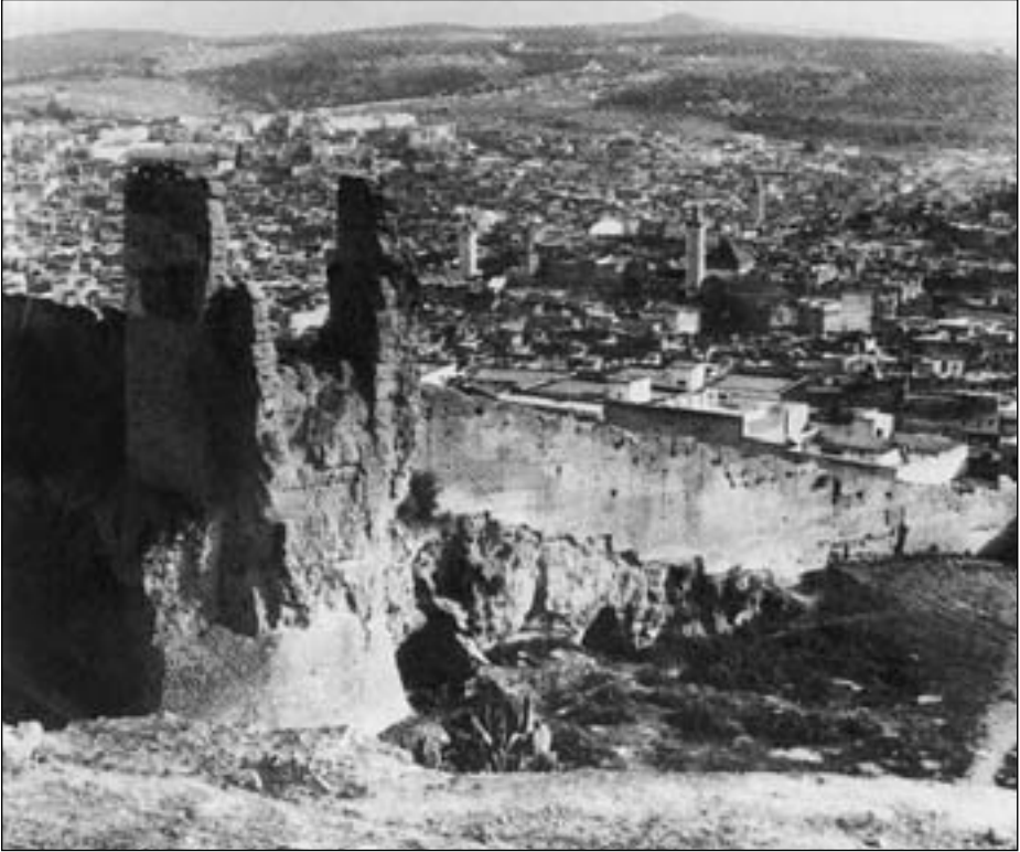
10.1. Vue générale de la vallée dans laquelle a été construite la ville de Fès ; au premier plan, la muraille externe de la ville remaniée à plusieurs reprises par les dynasties successives. [Source : Mohammed El Fasi.]
